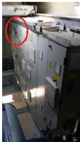
Fig. 1 y 2 - Se identifica con círculo rojo el FG004 en armario. Armario TOP – ALIMENTACIÓN DE MOTORES
