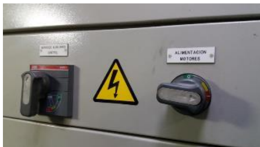
Fig. 3 - Detalle Compartimento F: FG16 en posición cerrado.
