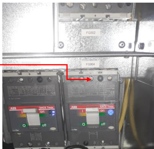
Fig. 4 - Detalle FG004 en posición cerrado.
