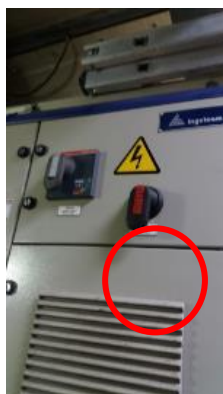
Fig. 3 y 4 - Compartimento D: FG004 en posición cerrado
