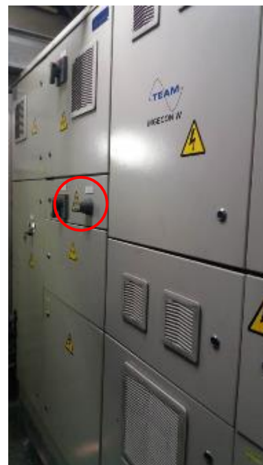
Fig. 1 y 2 - Se identifica con círculo rojo el FG16 en armario. Armario TOP – ALIMENTACIÓN DE MOTORES
