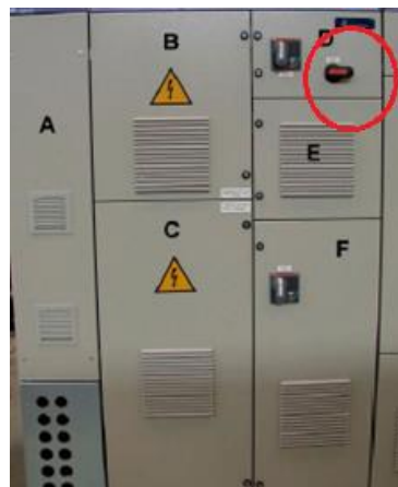
Fig. 1 y 2 - Se identifica con círculo rojo el FG004 en armario. Armario TOP – ALIMENTACIÓN DE MOTORES
